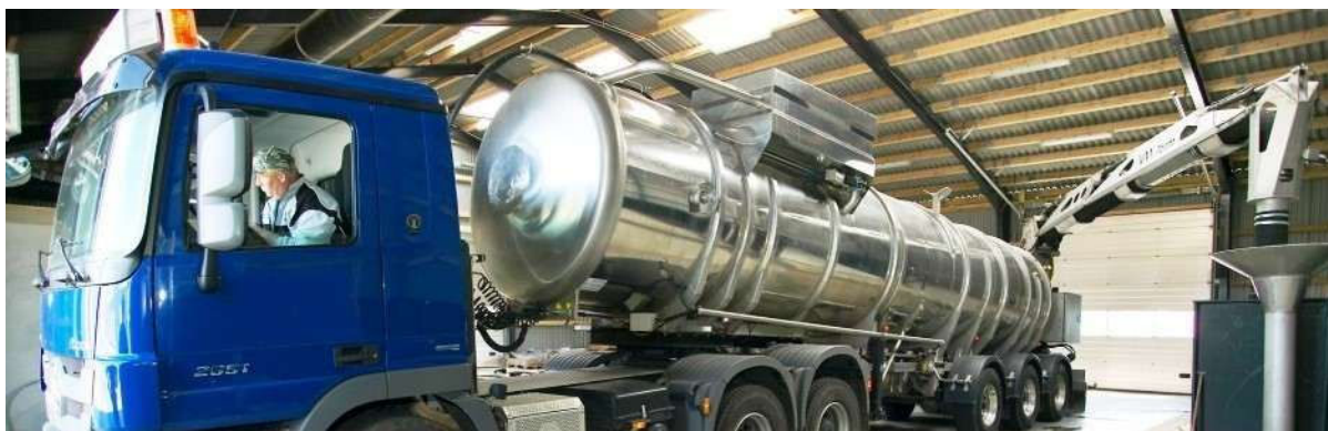
Figur 4-2 Mottak av flytende substrat vil foregå innendørs, med avtrekk og ventilasjon som renses før utslipp. Lossingen vil foregå med sugestuss for å hindre søl.
