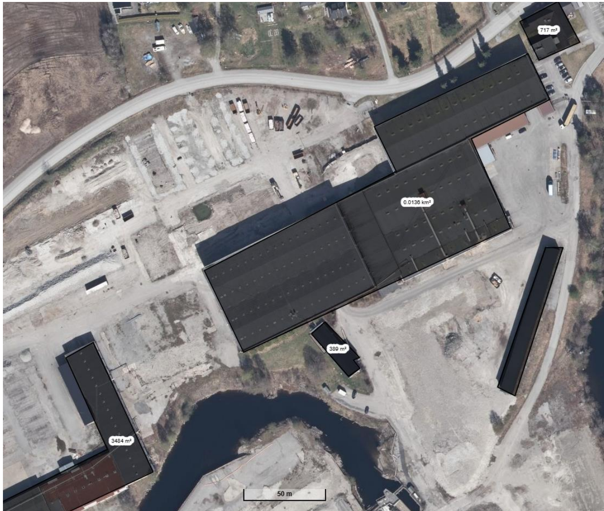
Figur 2. Utligjengelige arealer bygninger. Langstrakt bygning utgjør ca. 1000 m 2 .
