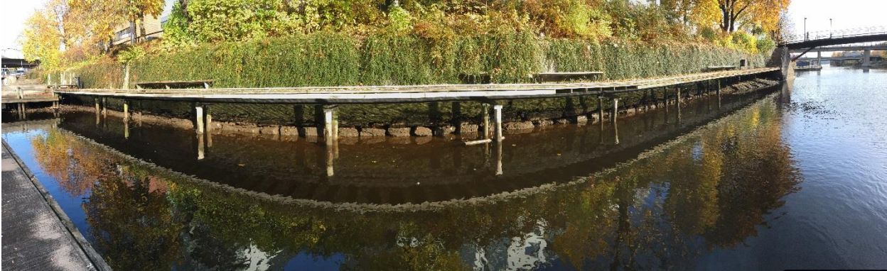
Figur 2.1 – Panoramabilde av eksisterende støttemur og brygge ved etappe 2 av prosjektet Sandvika elvepromenade.
