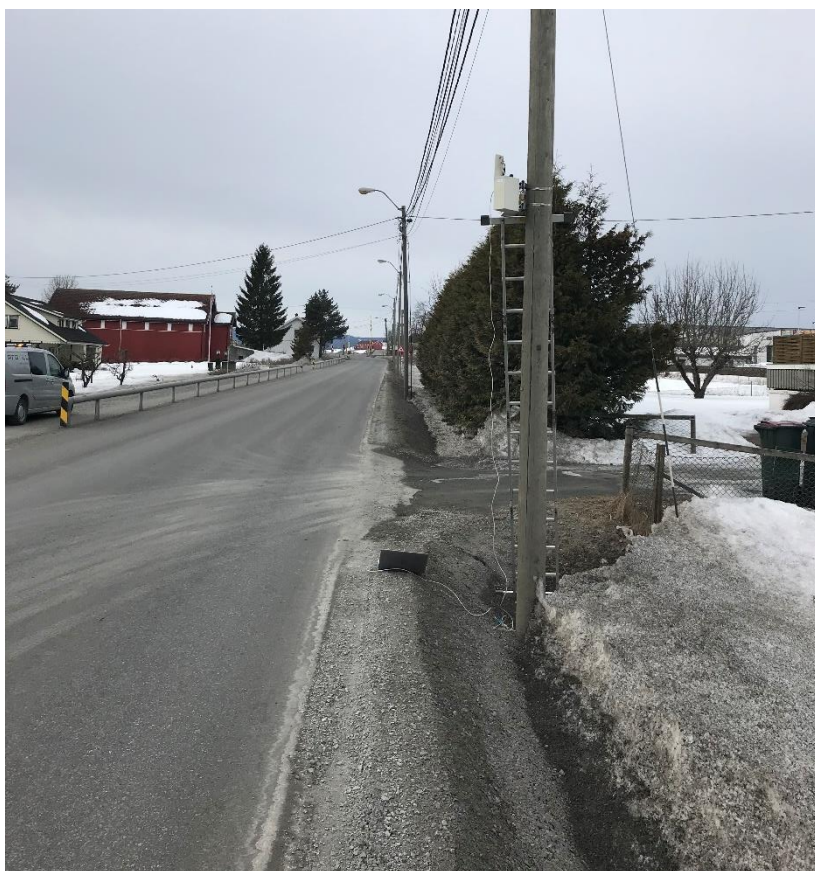
Radarplassering sett mot sør
