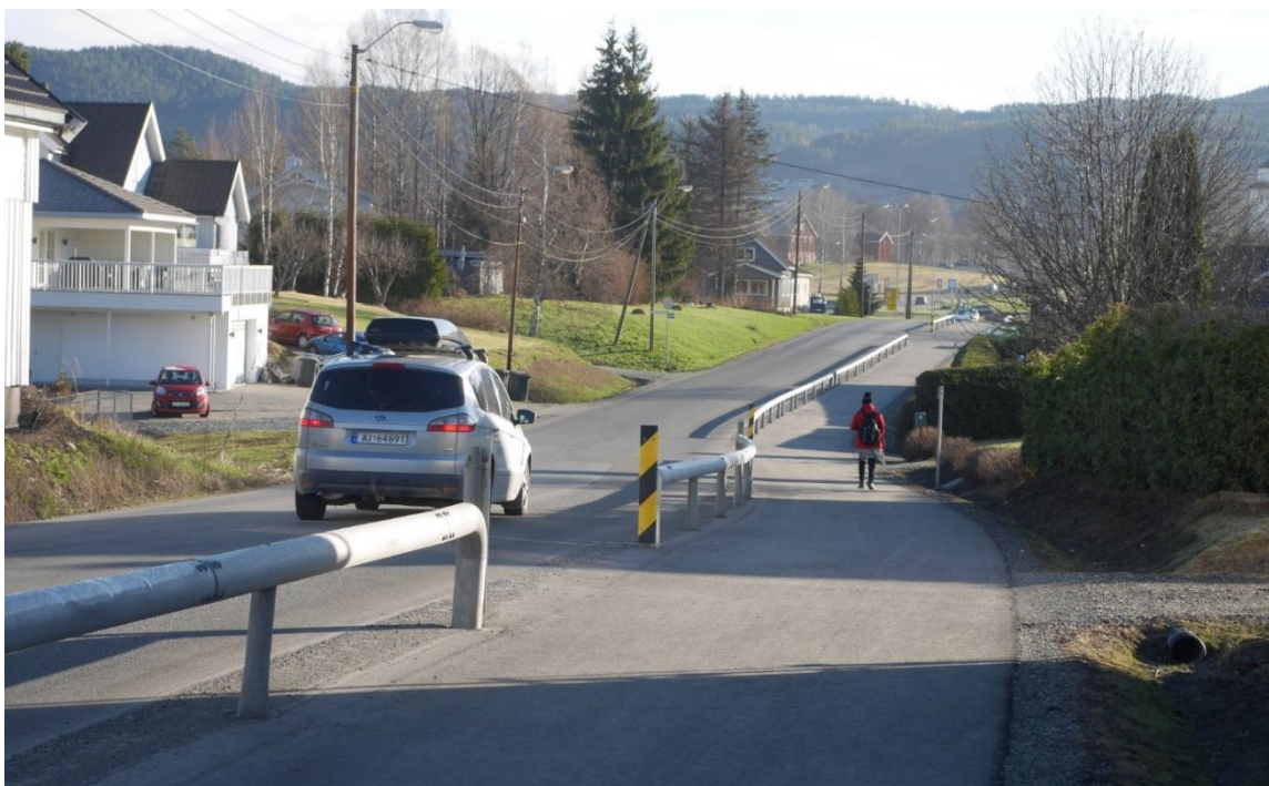
Gang- og sykkelvei i Semsveien (retning mot Langebru)
