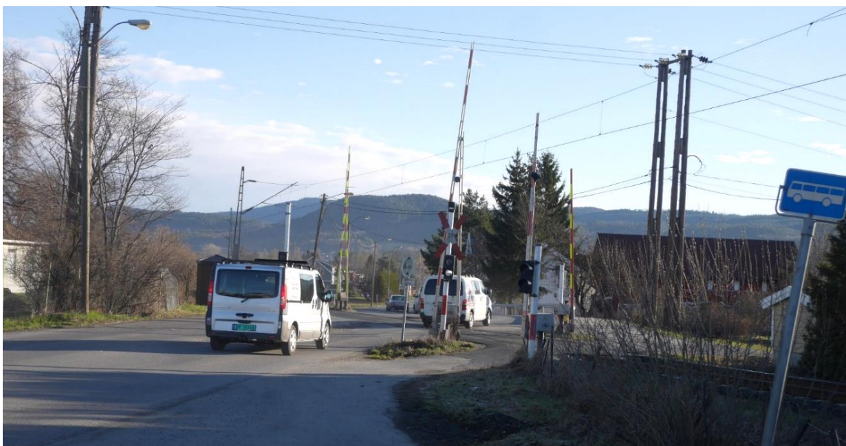
Semsveien ved næringsparken – plankryssing av Sørlandsbanen
