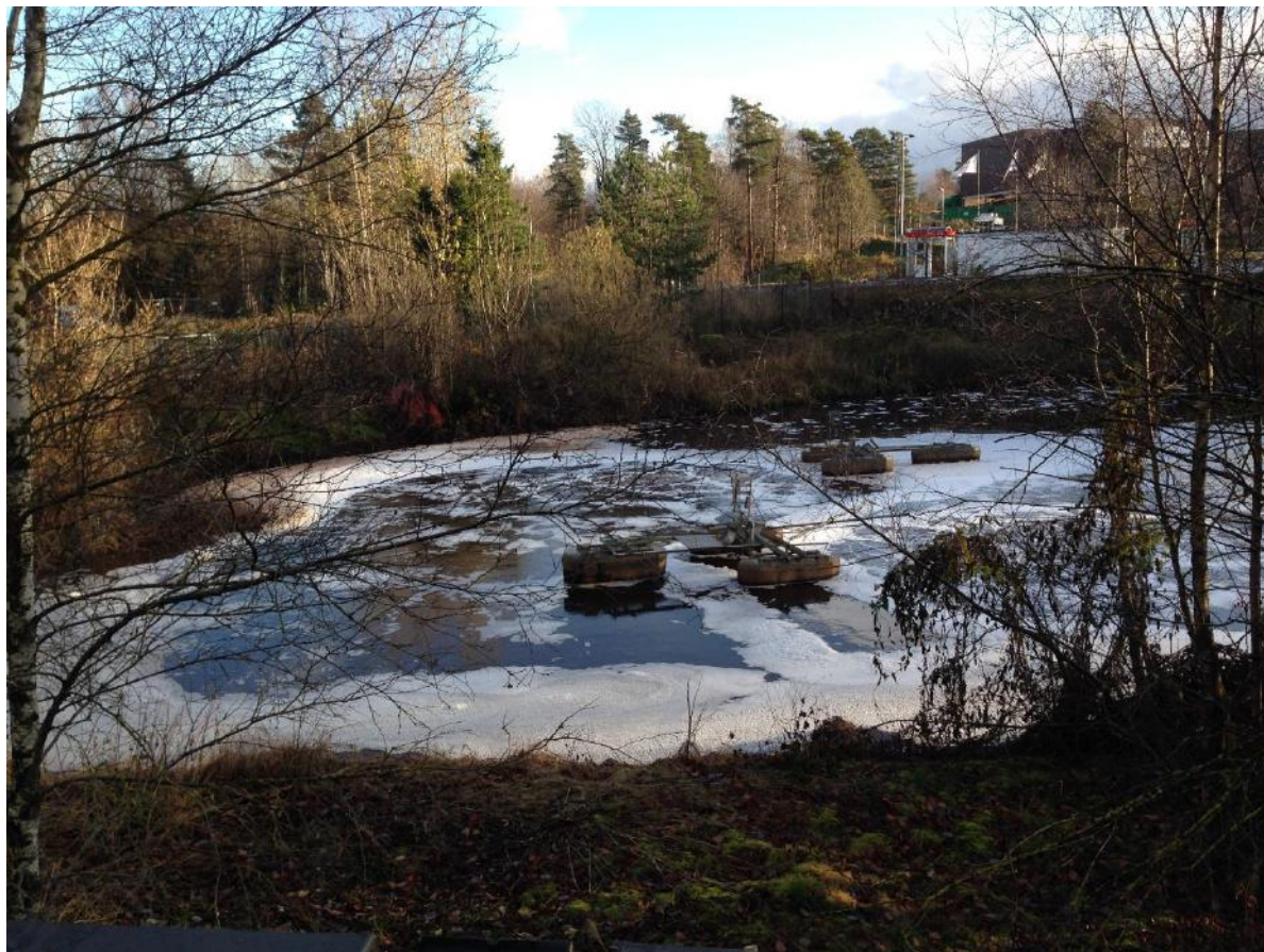
Figur 1: Viser sigevannsdammen nord på Solgård Avfallsplass sitt område hvor sigevannet pumpes til, om røres og luftes.
