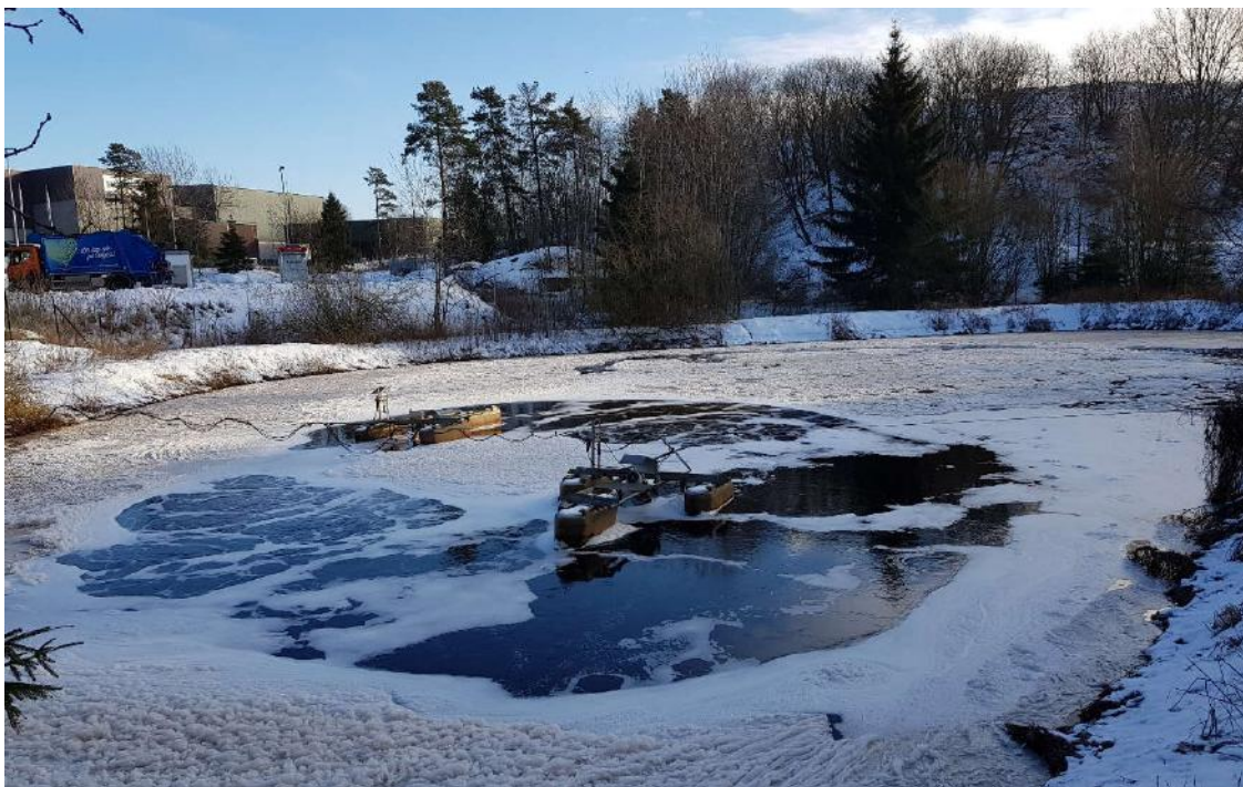
Sigevannsdam med to luftere
