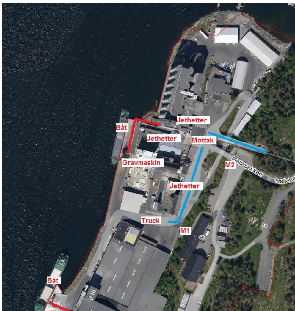
Figur 2: Oversikt over anlegget.
