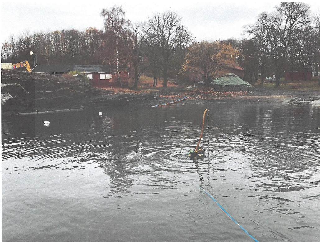
Bildet viser sondeboring med dykker.
