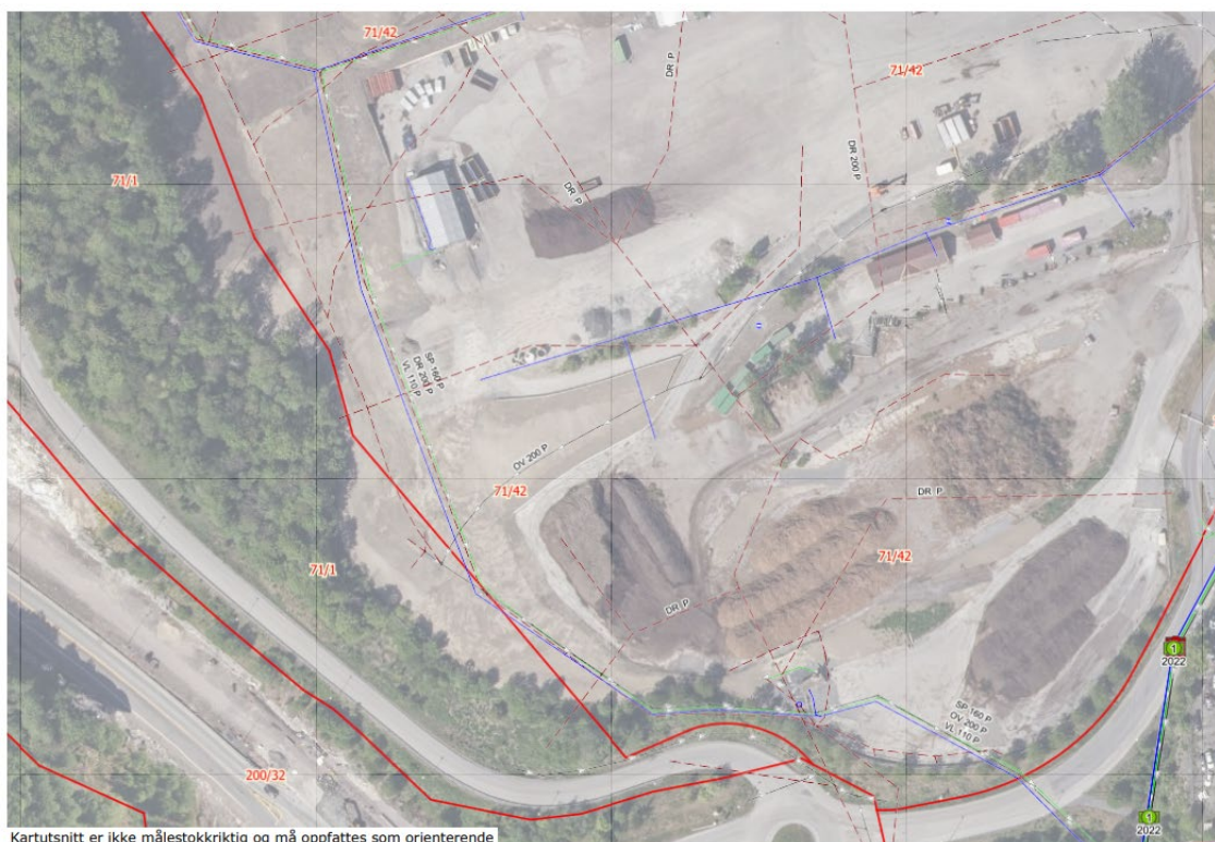
Figur 4: Bildet viser arealer som benyttes til mottak og midlertidig lagring av hageavfall samt ledningsnett som er anlagt for å fange opp avrenning av vann fra hageavfallet.
