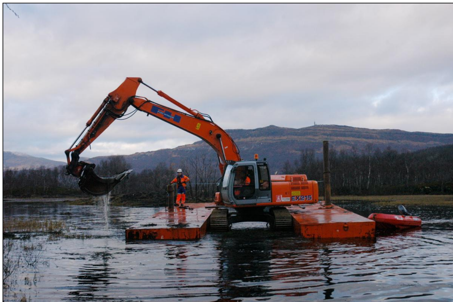
Flåtearbeid under graving i Børselva Foto: NVE
