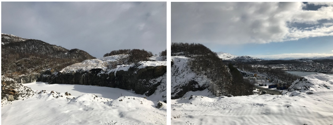
Bilde 6 og 7: På grensen mellom avslutningen av den nåværende og starten på den nye deponietappen for deponiet på Vikan
