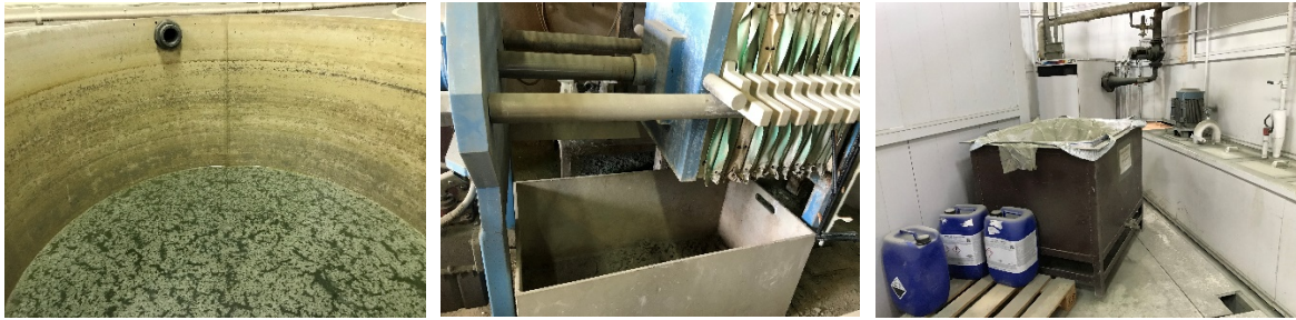
Bilde 4-6, del av renseprosessen med utfelling og oppsamling av hydroksidslam
