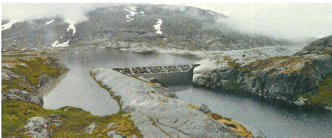
Figur 4.15 Dam Vakkerjordvatnet med hevet vannstand.
