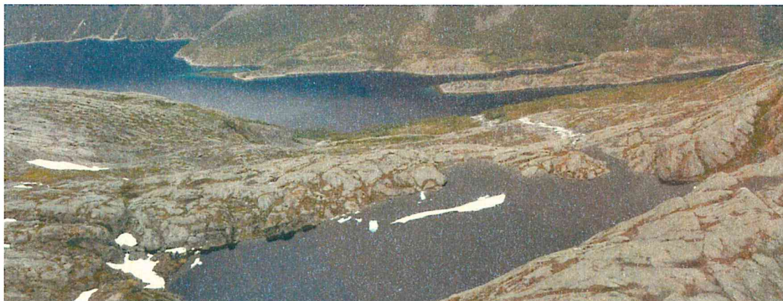
Figur 4.20 Mangåga løper ut til høyre i bildet, inntak blir til venstre i vannet og terskel ved utløpet, til høyre, sett mot nord. Konstruksjonene er små i det storskalalandskapet og vil ikke påvirke landskapsbildet i særlig grad.
