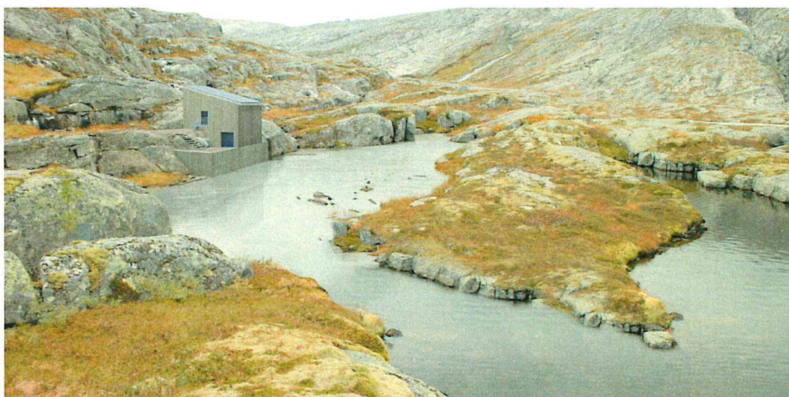
Figur 4.13 Området for pumpestasjon ved Vakkerjordvatnet, med og uten bygg, sett mot sørvest.
