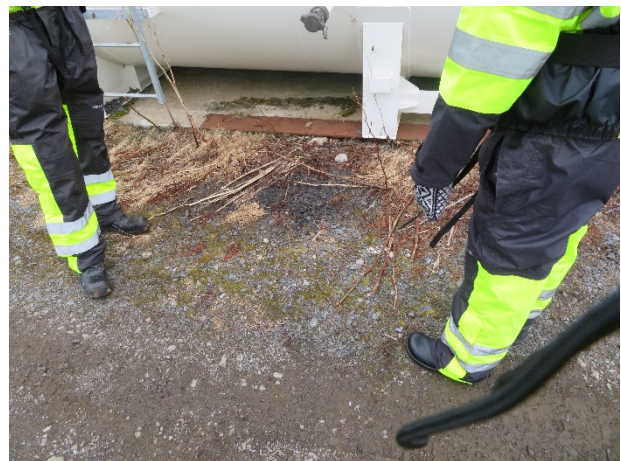
Bilde 4. Lekkasje fra påfylling av Diesel til grunn.
