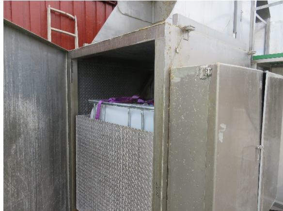
Bilde 2. ulåst tilgang til styring av tank og maursyre
