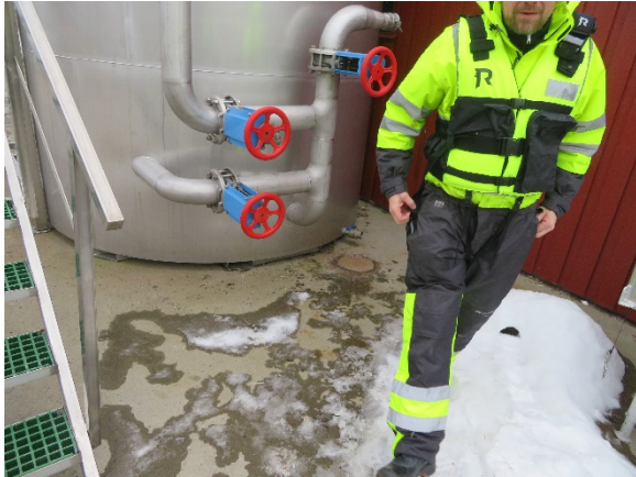
Bilde 1. Ensilasjetank med lett tilgjengelig mulighet for å åpne kraner
