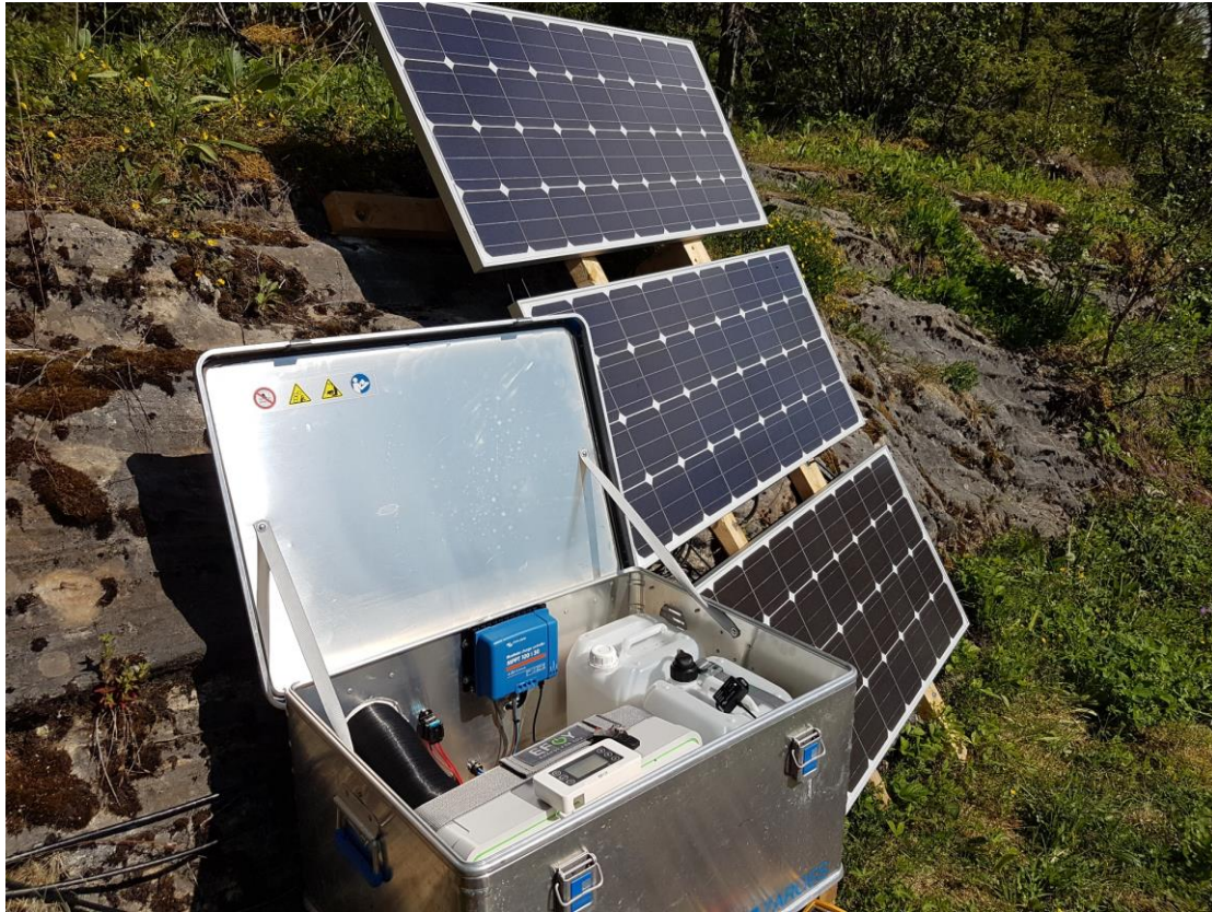
Figur 7. Solcellepaneler med brenselcelle som er montert i en aluminiumskasse med metanoltank, forsynte videosystemet i sausvassdraget med strøm i Sausvassdraget i 2017.
