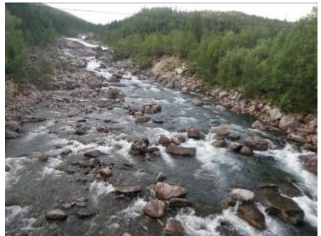
Ovenfor brua (mot vandringshinderet) i Helgåa
