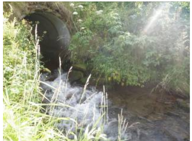
Durmålsbekken, neste kulvert
