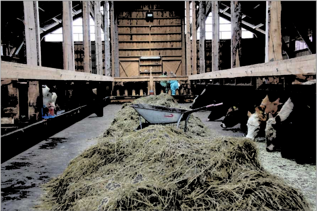
Figur 13. Tre innredning gir et trivelig inntrykk. Merk den breie fôrgangen og skråstilte nakkebommer.
