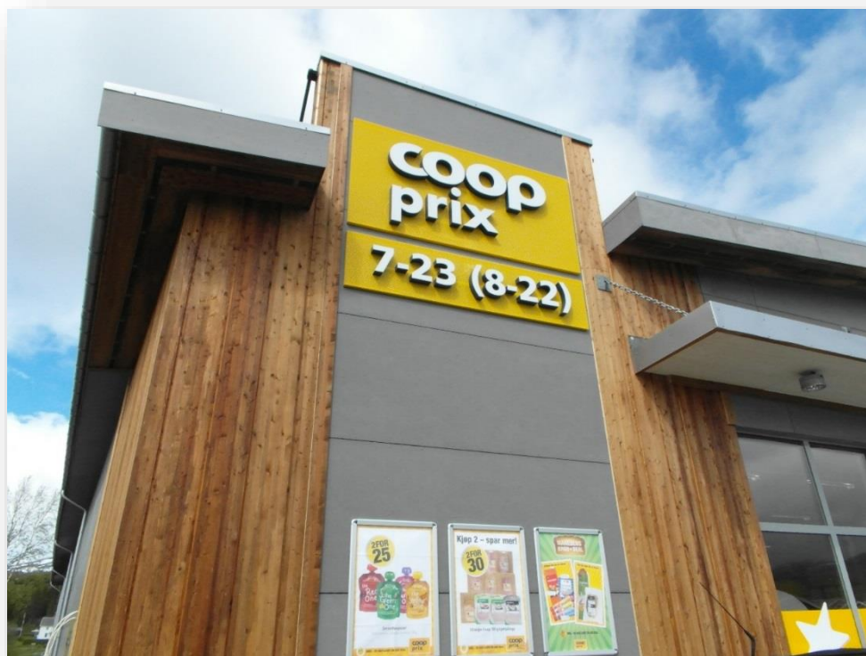
Coop Valnesfjord i massivtre.
