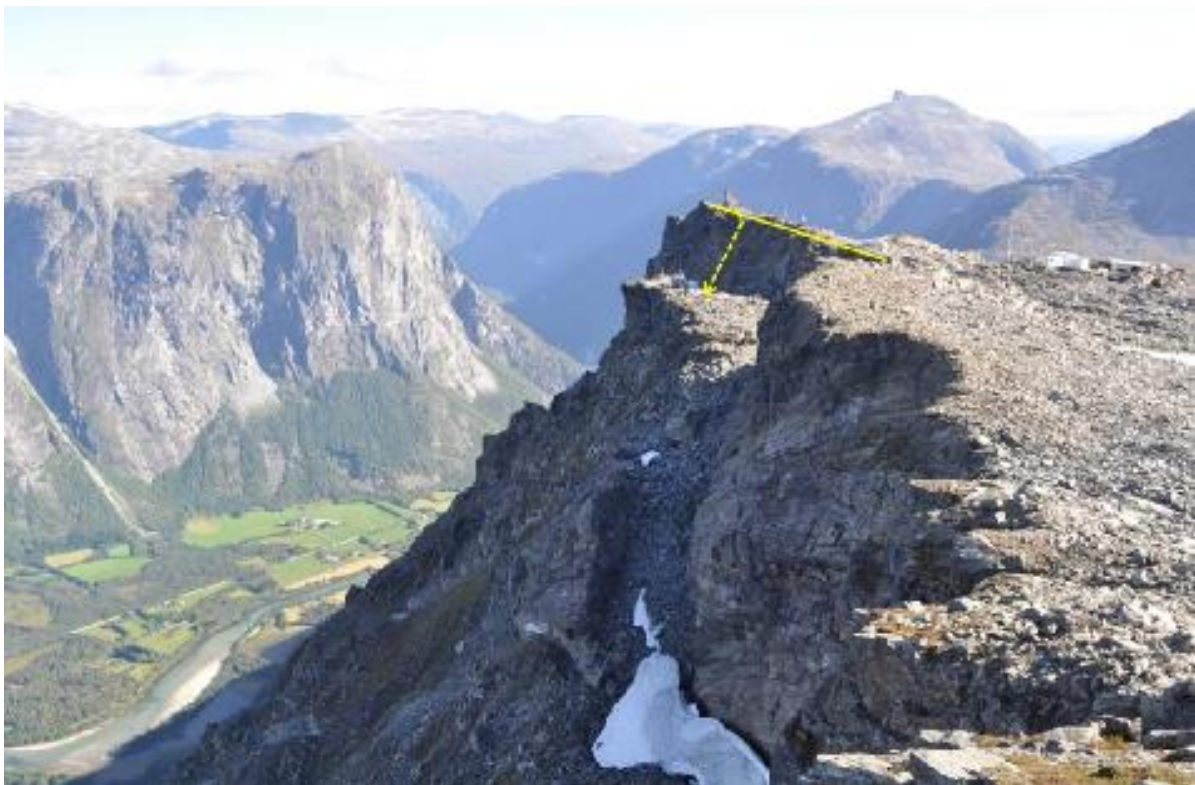
Figur 2-2 Foto av det ustabile fjellpartiet ved Mannen.
