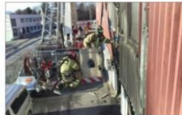
SKADE: Fasaden på Triangelgården har fått en del røykskader. Brannvesenet kunne fortelle at det mest sannsynlig kun hadde brent inne i transformatorrommet, og at det derfor ikke var snakk om store skader. FOTO: JAN OVE STEFFENDER
