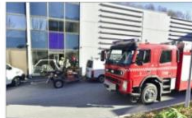
SYNDEREN: En feil i Hølen transformatorstasjon i Breivika førte til strømbruddet som gjorde Ålesund og flere nabokommuner strømløse i går formiddag. FOTO: STAALE NÆTT
