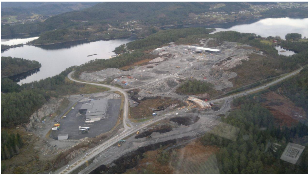
Figur 38. Svortavikbekken kan skimtast framføre dei nye fyllingane, og heile den nedre delen er no sterkt nedslamma, utretta eller utsprengt (nytt elvelaup). Dette kan ha fått fatale følgjer for somme sjeldne og kravfulle artar. Situasjonen har forverra seg mykje etter at dette bildet vart teke 23.10.2011.
