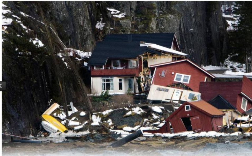
SKRED: Kvikkleireskredet i Kattmarka i Namsos i mars 2009 tok med seg fire hus og seks hytteeiendommer, og ble utløst av fjellsprengning på et sørenden av rasområdet. FOTO: Scanpix
