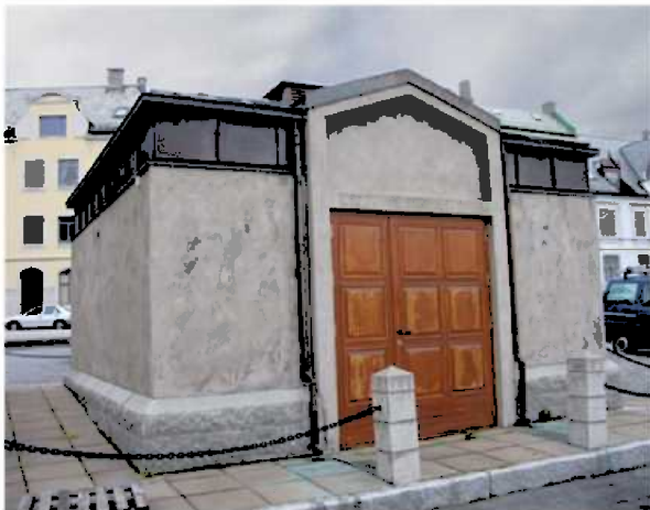
Bilde 2 - Pumpestasjon Prestebrygga
