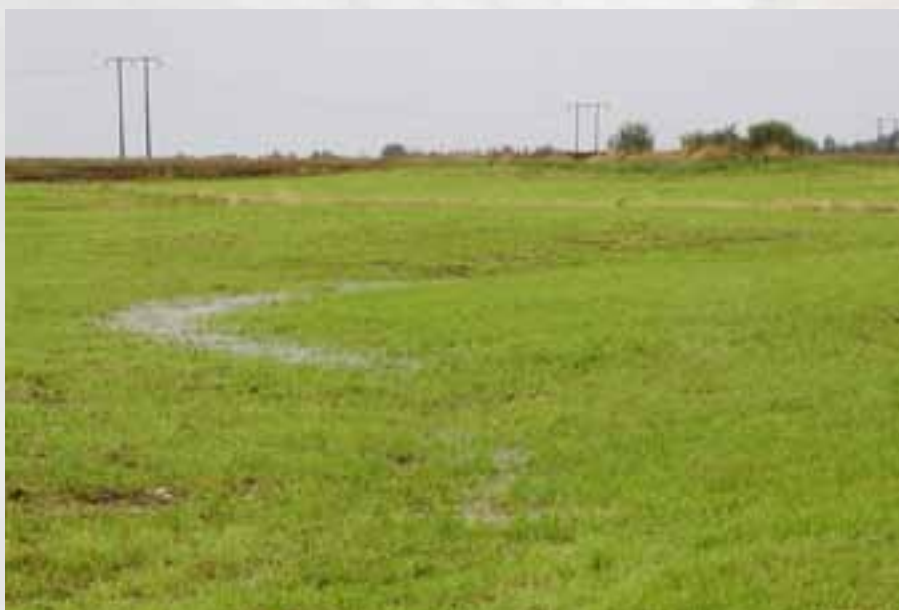
Bileta syner dreneringsarbeid på Smøla. På det nederste biletet er dreneringsarbeidet ferdig. Etter heftig regn samlar overflatevatnet seg over grøfta. Vatnet sig ned og blir drenert vekk gjennom grøfterøyren. Foto: Olav Inge Edvardsen.
