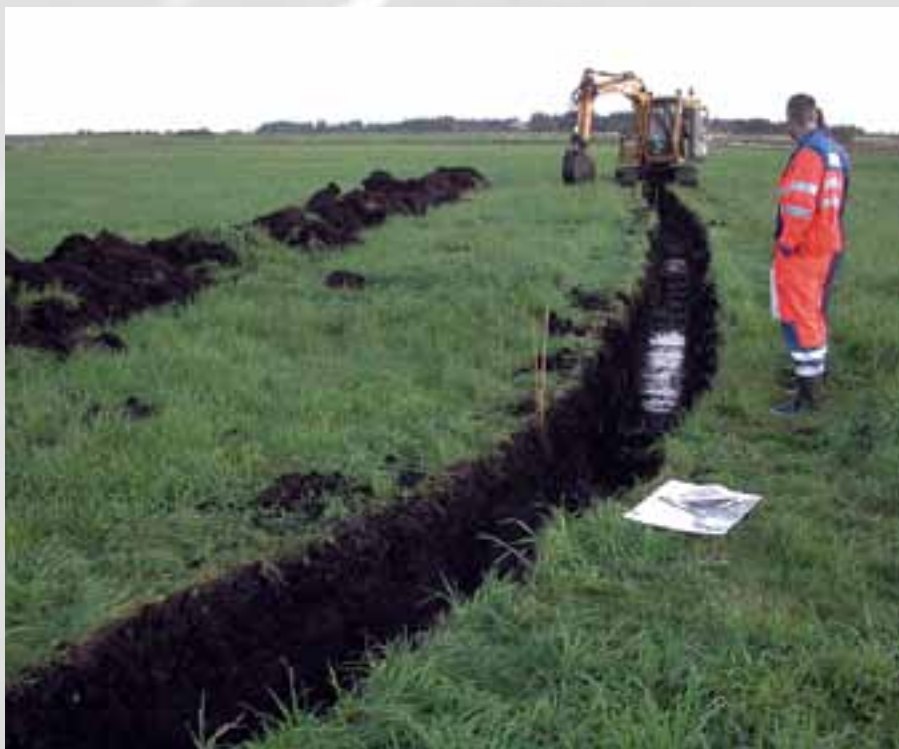
Bilete nr 2: Grøfting av myr på Smøla. (Foto: Olav Inge Edvarsen)
