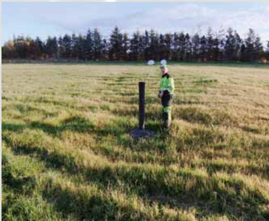
- Rask fjerning av overflatevatn er viktig. Overflateforming og sluk er effektivt. Peder har gode røymsler med dreneringsrøyr i singelsluk. Desse kan reinskast med spyling eller bruk av vakumvog. Røyrret på biletet er 8 tommar i diameter. Det blir kutta ned til overflata, og dekt med sterk rist. Foto: Olav Martin Synnes.
