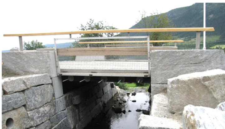
Klokkarjordet og Hellingvegen Bru. Små treplatebruer. Hol kommune (2008)
