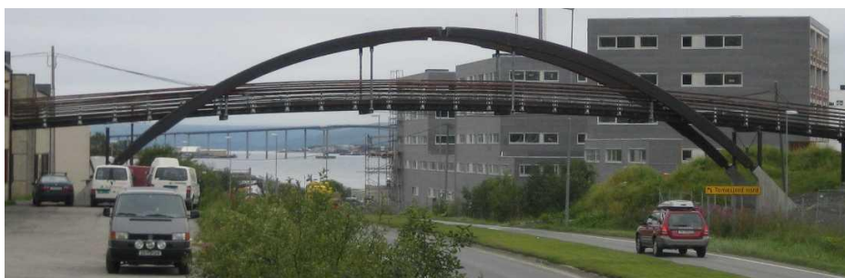
Tomasjordnes Nord. GS-Bru over Fv. 53. Tromsø kommune (2005)
