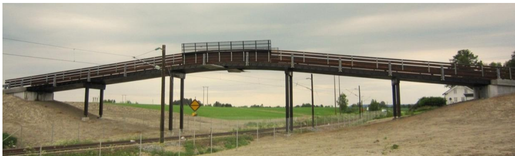
Løkenporten Bru. 50 m lang platebru over jernbane. Nes kommune (2010)
