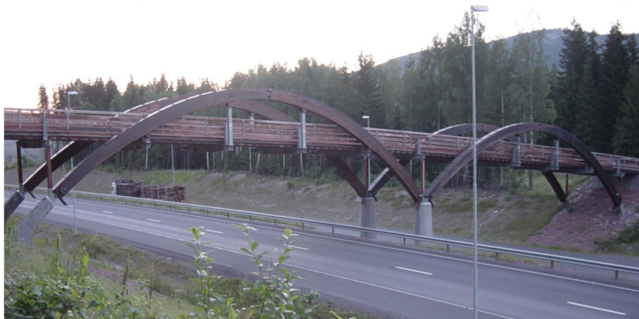
Daleråsen Bru. Vegbru over E134. Nedre Eiker kommune (2000)
