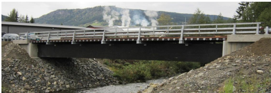
Steinsmoen Bru. 28 m bjelkebru over elv. Gausdal kommune (2010)
