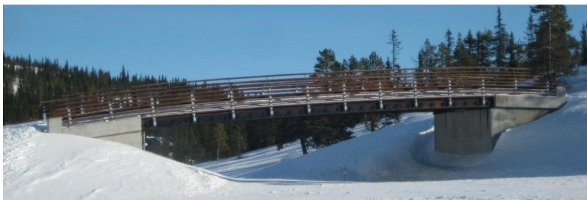
Bøeseter skibru. 19 m lang platebru over veg. Norefjell (2008)
