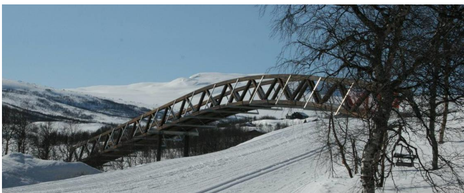
Maurseth bru. Gangbru over Rv 7 på Hardangervidda (2007)
