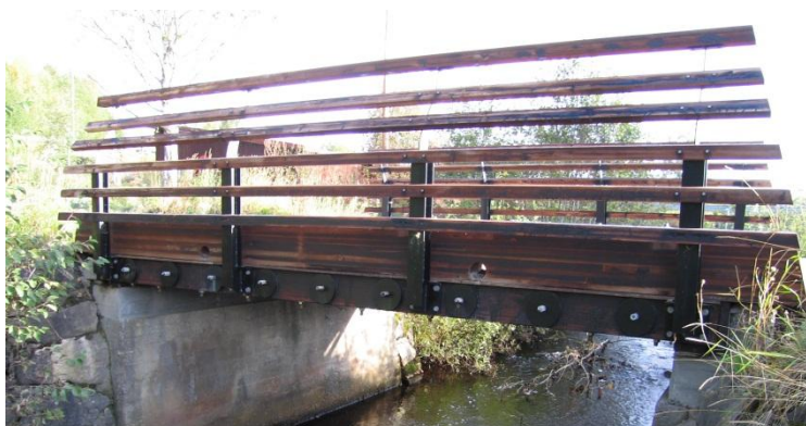
Veenslivegen Bru. GS-bru over bekk. Løten kommune (2005)
