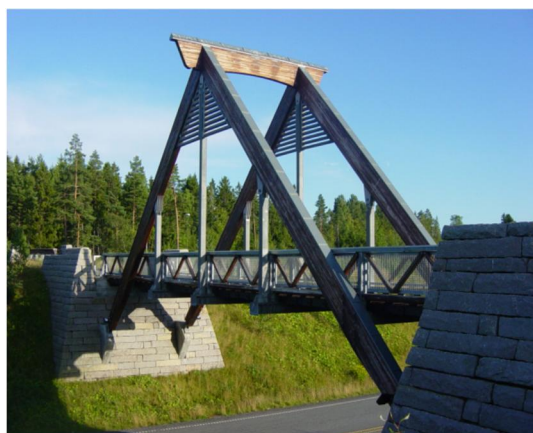
Måna Bru. GS bru over Rv 23. Oslofjordforbindelsen (2000)
