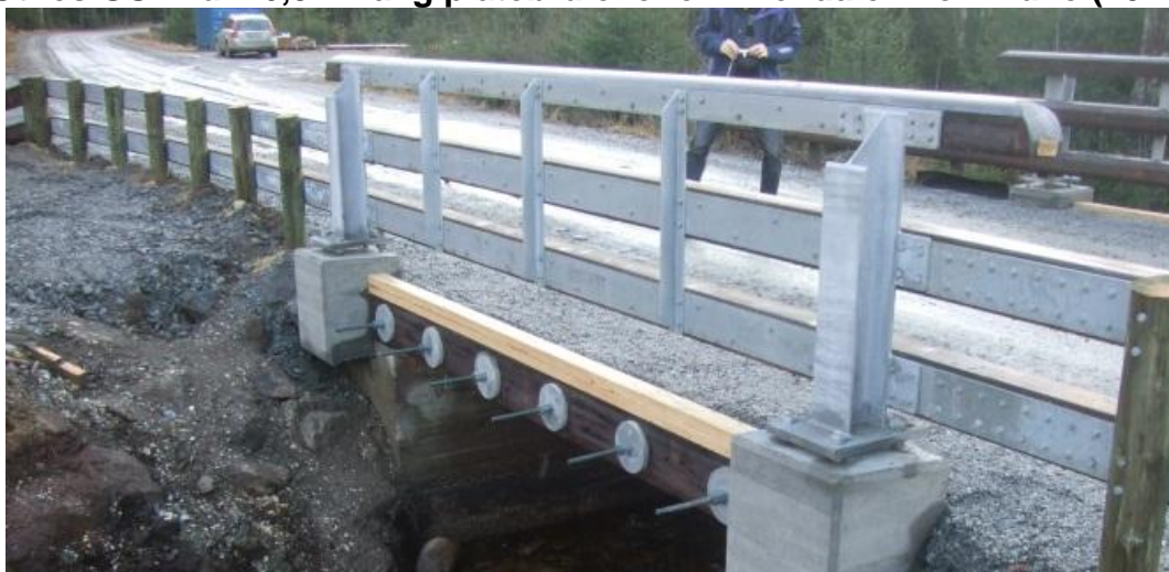
Børåa, Skvalafoss, Flombekken og Hvitsten bruer. Vegbruer over bekker. Akershus (2012)
