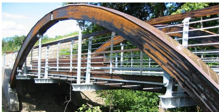
Bekkedalsbrua. Gangbru langs Rv 4 over bekk. Oslo kommune (2002)
