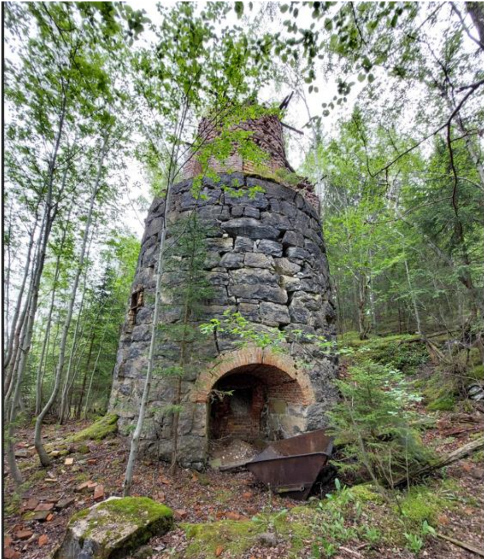
Den midtre kalkovnen i Bergevika. Foto Ringsaker kommune.
