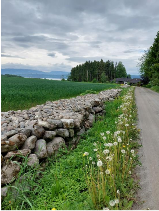
Restaurert steingjerde på Skavang. Foto Ringsaker kommune
