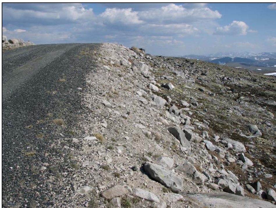
Figur 22. Snøheimvegen er stedvis bygd med mye tilførte masser som må fjernes ned til opprinnelig terreng for å oppnå god effekt for landskap og grunnlag for gjenvekst. Spesielt i høyere-liggende områder vil det ta lang tid før det etablerer seg vegetasjon i tilbakeført veg. Foto: D. Hagen.
