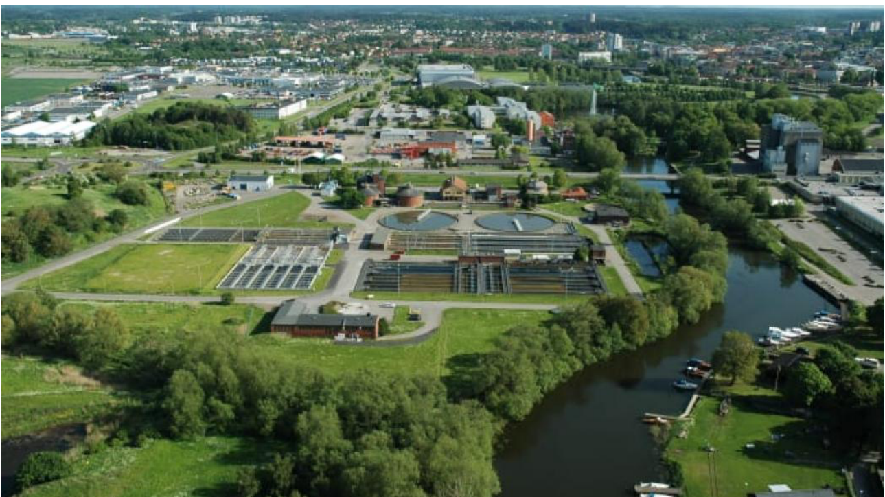
Nykvarnsverket avløpsrensaneanlegg i Linköping ble i 2017 bygd ut med et ekstra rensetrinn for å bryte ned legemiddelrester og organiske miljøgifter. Foto: Tekniska Verken
