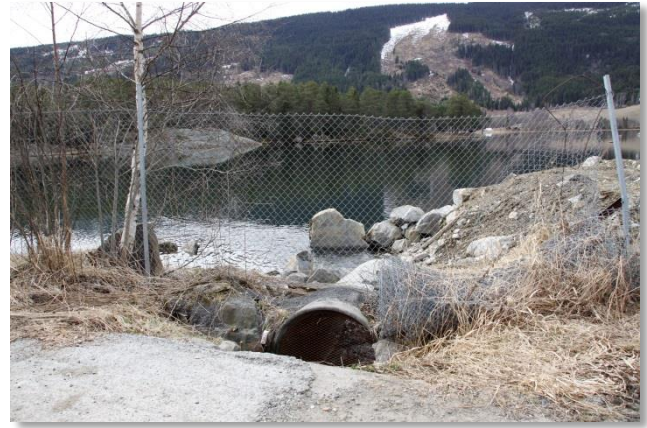
Figur 35. Produksjonsdammer ved Røn Gard (venstre bilde). Avløpet til Ferisfjorden (høyre bilde). Anlegget har ikke sedimentasjonsbasseng for avløpsvann.
