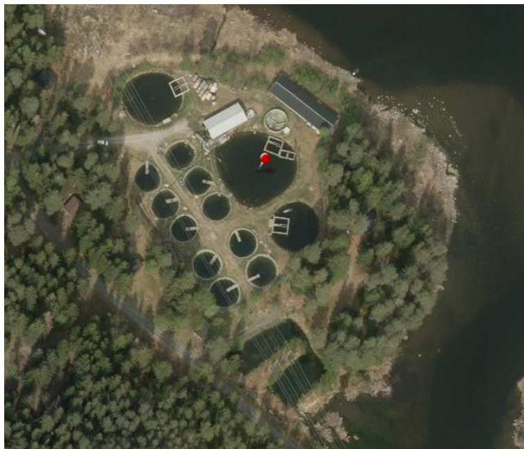
Figur 44. Flyfoto av Haadem Fisk med produksjonsdammer og sedimentasjonsbasseng. Anlegget for settefiskproduksjon er ikke vist på bildet.
