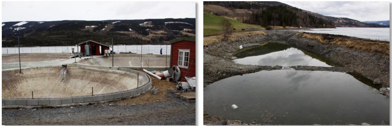
Figur 25. Produksjonsdammer (venstre bilde) og sedimentasjonsbasseng ved Hande Gard.
