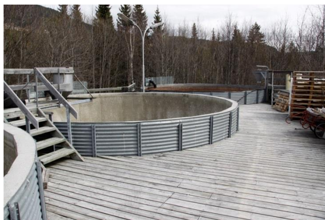
Figur 3. Produksjonskar (venstre bilde) og sedimentasjonsdam ved Lofoss Fisk. Utløpet fra dammen går via bekk til Begna.
