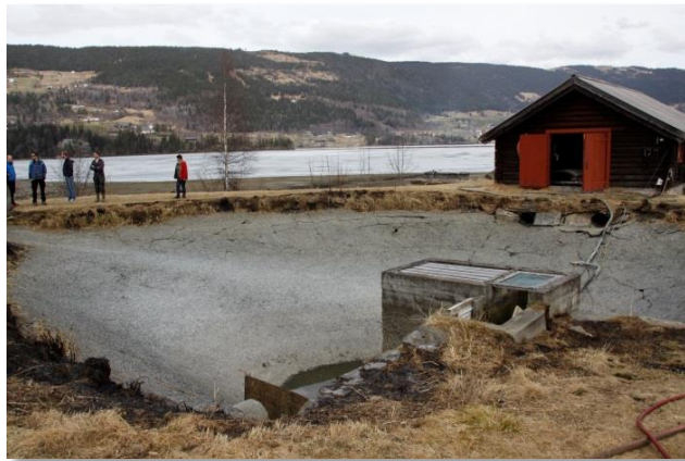
Figur 14. Sedimentasjonsbassenget (støpt i betong) ved Trøsvik Gård.
