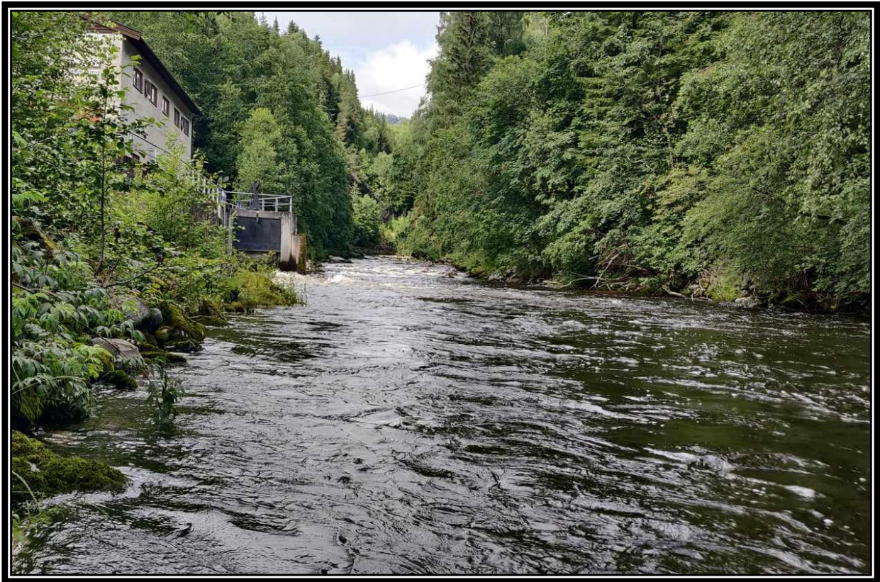
Våla ved Vinkelfallet kraftverk (2023) Foto: Sondre Røragen
