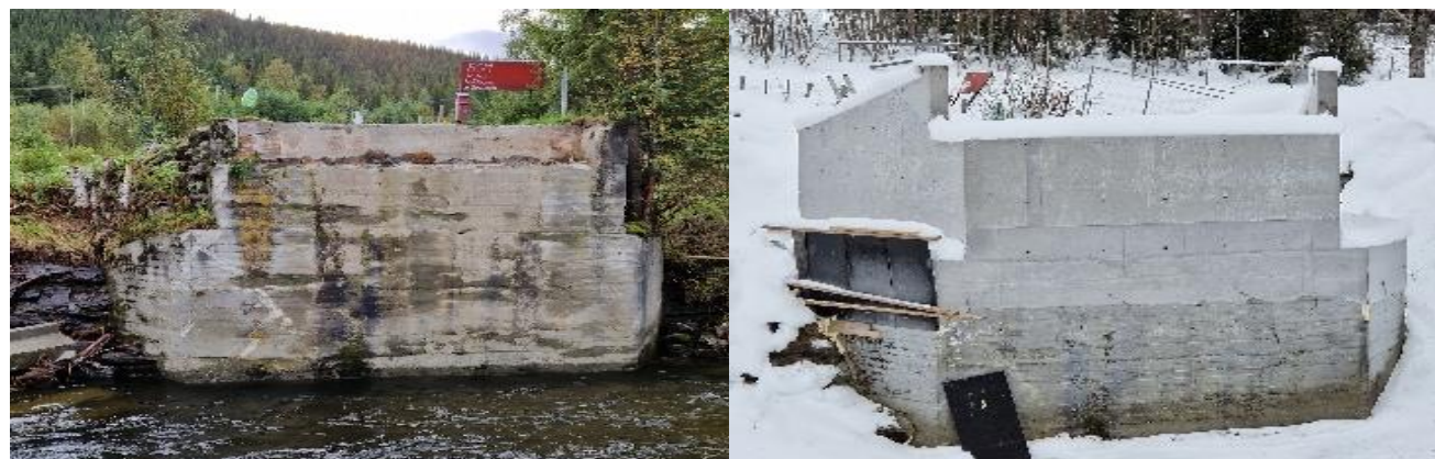
Bilde 4 & 5: Oppdimensjonering av ødelagte kulverter og bruer etter flomskader under ekstremværet Hans til å tåle større nedbørmengder kan være et viktig tiltak på skogbilvegnettet. Foto: Carl Olav.Holen
