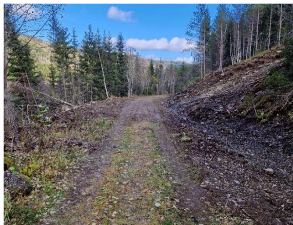
Bilde 7: Fjerning av vegetasjon, grøfte og skråningsrensing og nytt slitelag må til på mange skogsveger. Foto: Carl Olav Holen
