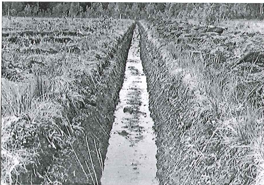
Resultater etter maskingrøfting
