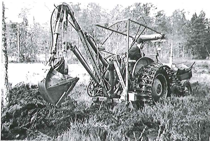
Grøfting med gravemaskin 1958.
