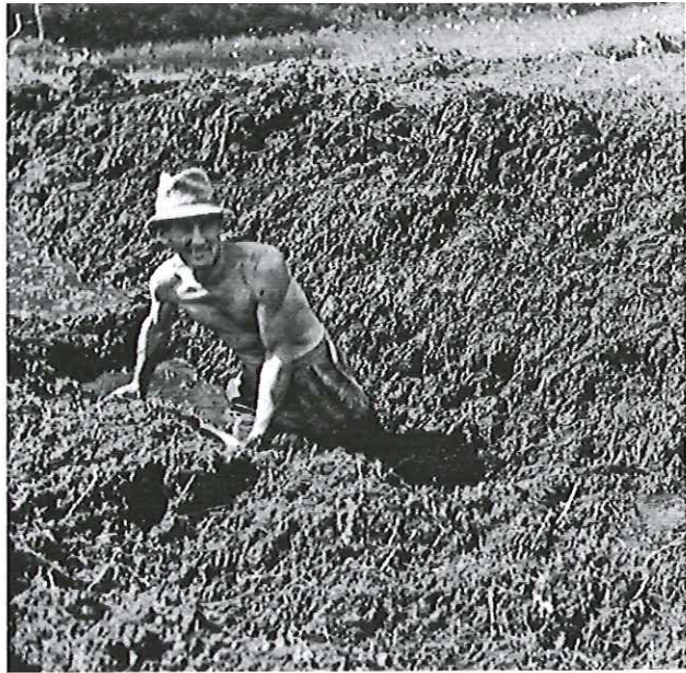
Opprensning etter grøftesprengning, Prestebakke
