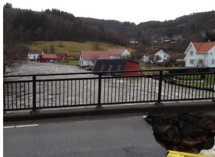
Ødelagt sjøbod i Feda (Foto: Fylkesmannen i Vest-Agder)
