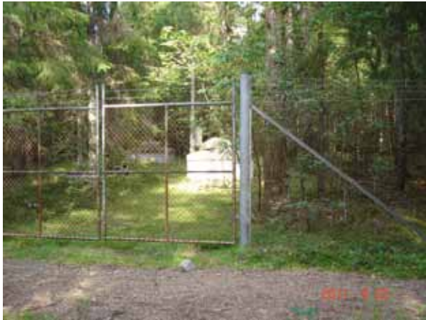
Figur 139: Vannreservoaret som ikke lenger er i bruk fjernes. Foto: Karin Guttormsen
