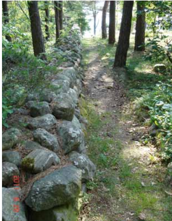
Figur 37: Steingjerde på yttersiden av Tromøya. Foto: Karin Guttormsen
