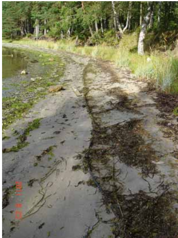
Figur 131: Plastledning ute av bruk som bør fjernes.
