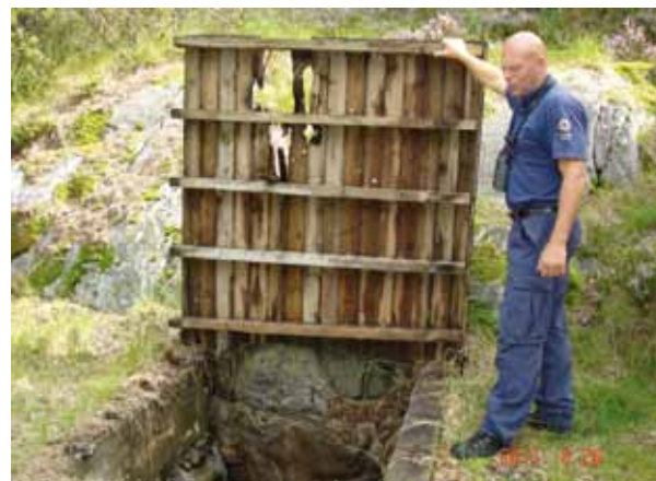
Figur 82: Brønnen ved Blåskjellhytta som ikke er sikret, sjekkes her av SNO. Foto: Karin Guttormsen
