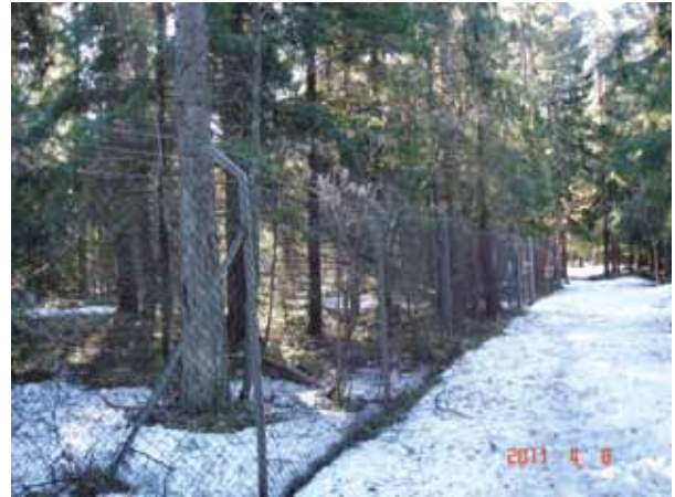
Figur 140: Inngjerding til vannreservoaret fjernes. Foto: Karin Guttormsen
