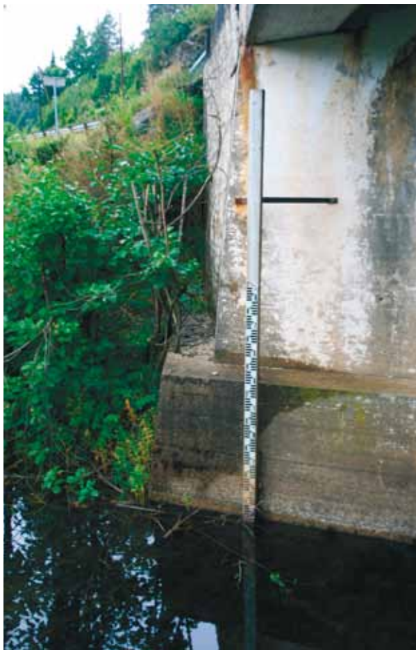
Vanntålestokk som er satt opp ved utløpet på Berse.
