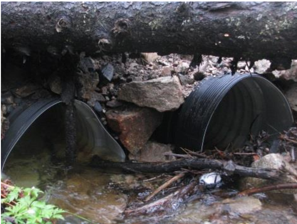
Figur 9: Stikkrenner på skogsbilveien i Vennesla. Stikkrennene er tettet igjen og plassert slik at veimasser har rast ut. Foto: Ole Stabekk.
