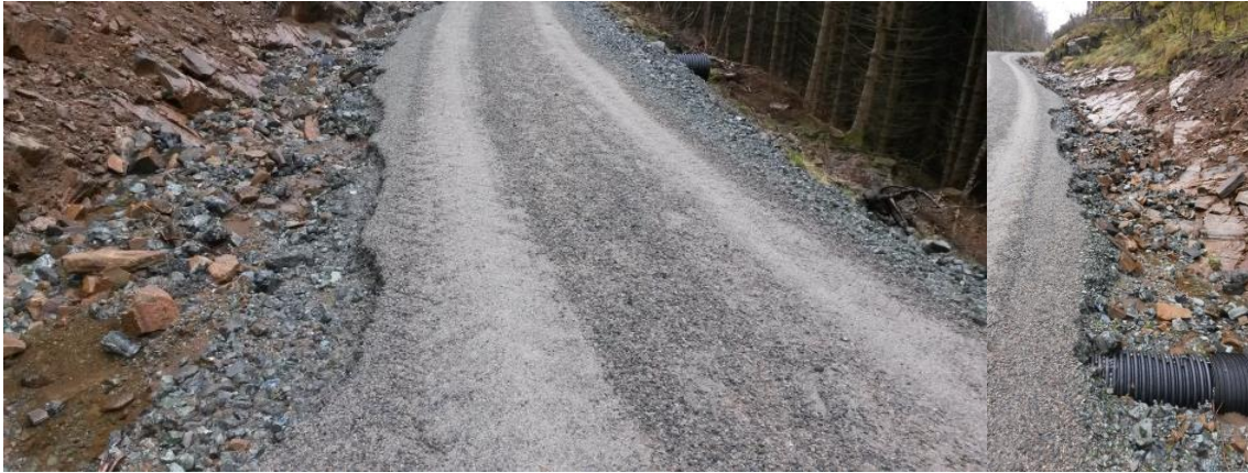
Figur 8: En flomepisode i Farsund i 2014 medførte veiskader grunnet feilvurderinger gjort ved en av stikkrennene lagt i 2012. Veien ble i etterkant utbedret. Foto: Jan Fredrik Sundt.
