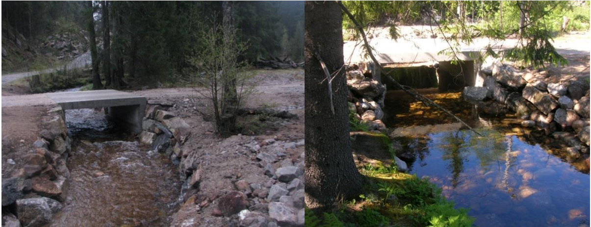
Figur 5: En betongbro på skogsbilvei i Vennesla. Et godt eksempel på klimatilpasningstiltak ved skogsveibygging. Foto: Ole Stabekk (venstre bilde) og Rune Iveland (høyre bilde).
