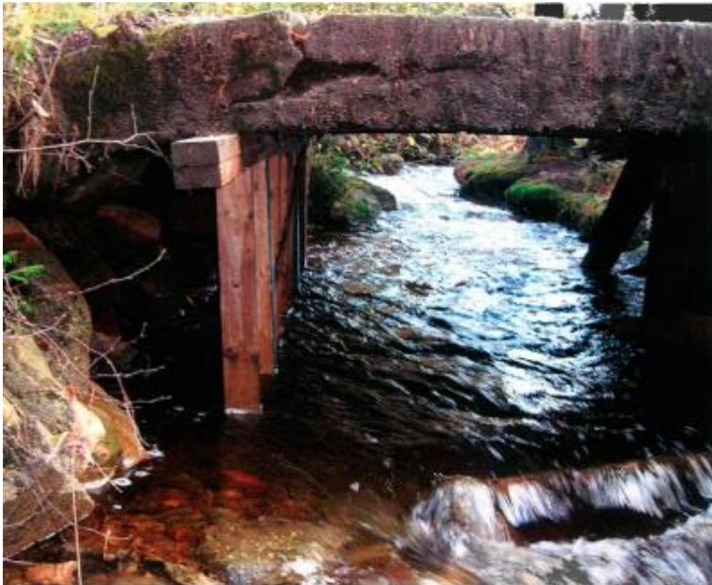
Figur 4: En betongbro i Vennesla er i dårlig stand. Brohodene har rast ut og betongplaten har begynt å slå sprekker. Det er ved ombygging av broen foretatt en vurdering av hvilken løsning som vil være best med tanke på framtidig ekstremnedbør. Foto: Rune Iveland.
