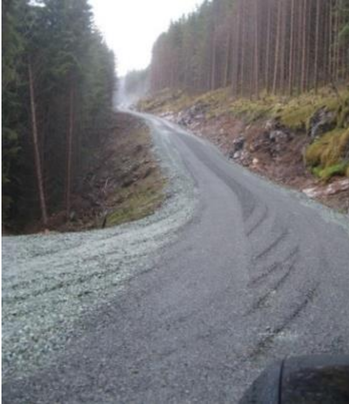
Figur 7: En vei i Farsund ble ombygd i 2012 etter at en flomepisode hadde medført skader på veien. Det ble i en lengre bakke gjort feilvurderinger ved dimensjoneringen og plasseringen av en stikkrenne. Foto: Jan Fredrik Sundt.
