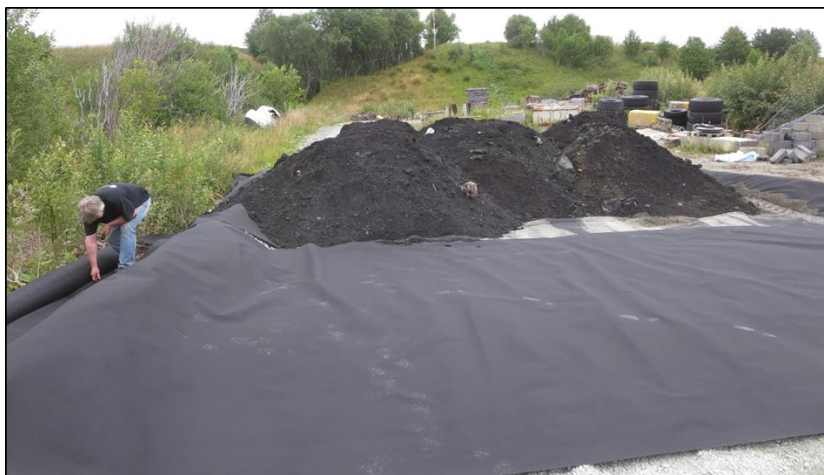
Figur 9. Eksempel på mellomlager med bunn og voller av subus som igjen dekkes av fiberduk.
