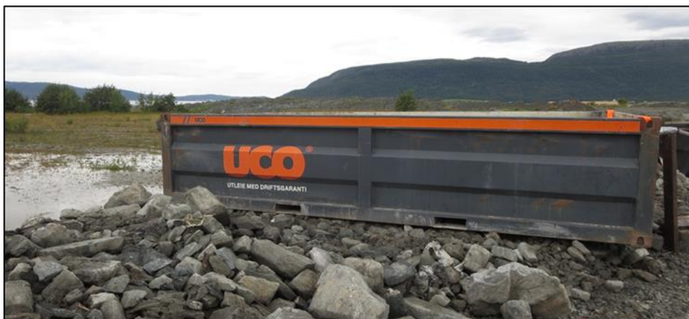
Figur 8. Eksempel på 3-kamret slamavskiller for å fjerne partikler i forurenset nedbørs-/overvann.
