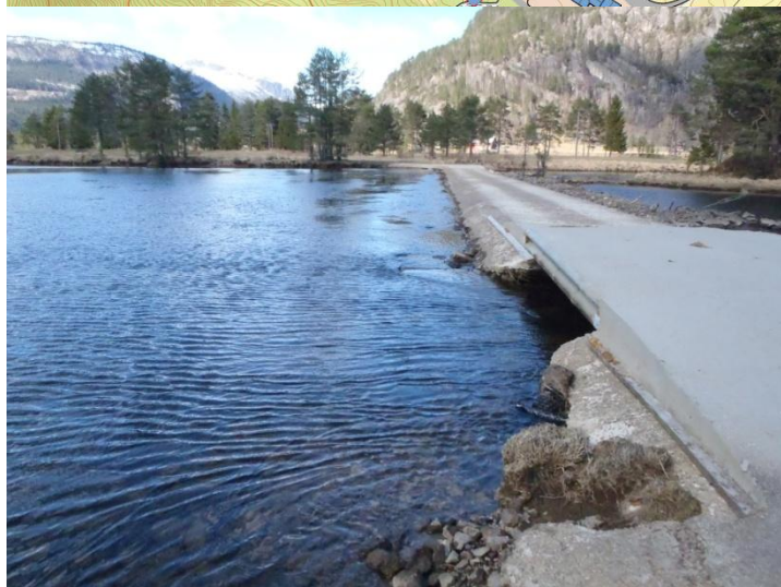
Terskelen over sideløpet sett fra søndre side, Øyna i bakgrunnen. Synlig er også en av to åpninger i terskelen. En krypsivmatte er skyllet opp på terskelbasis i forgrunnen.
