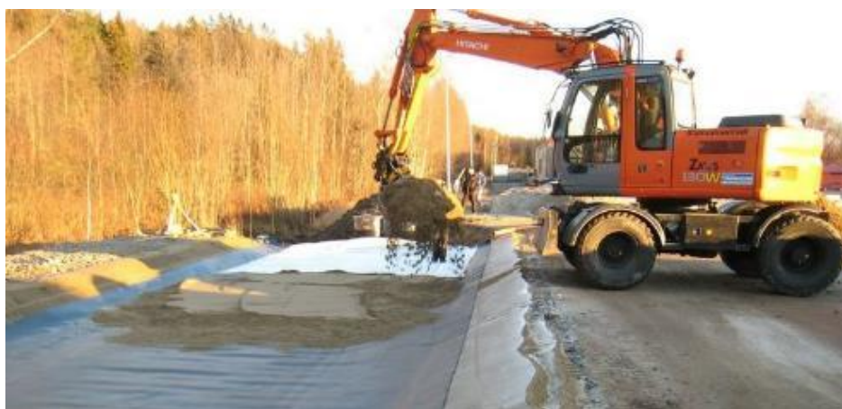
Figur 13: Bygging av spyleplass med helling til 3-kammer brønn (Axon Miljøteknik AB).
