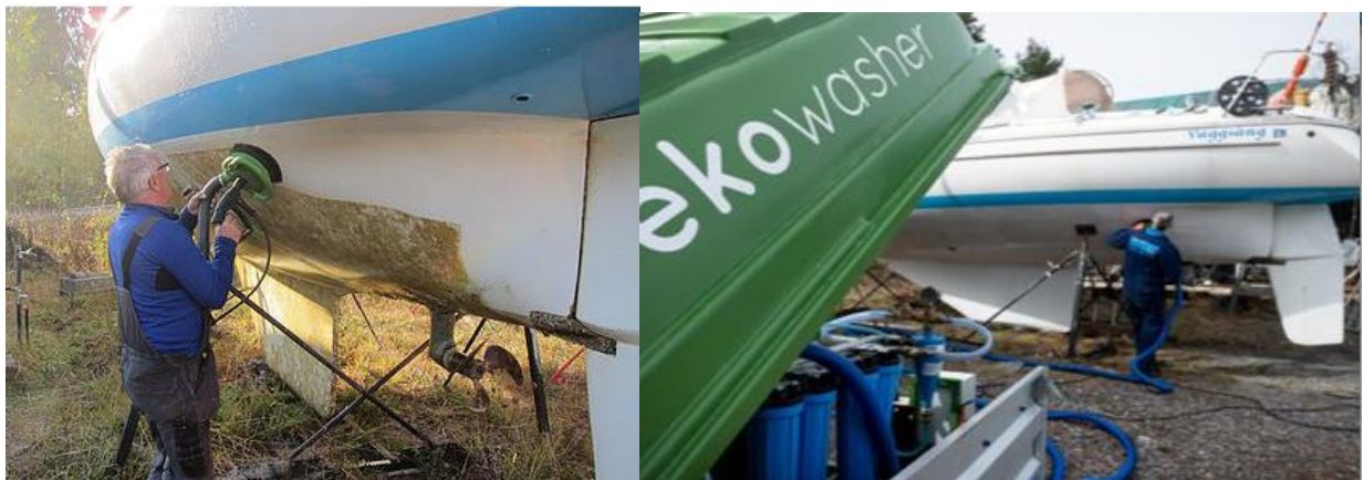
Figur 19: Bilder av mobilt spyle- og renseanlegg ( www.ekowasher.se )
