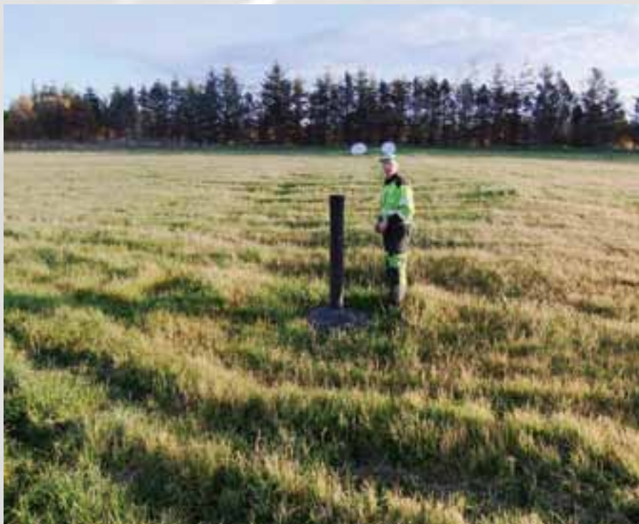
- Rask fjerning av overflatevatn er viktig. Overflateforming og sluk er effektivt. Peder har gode røynsler med dreneringsrør i singelsluk. Desse kan reinskast med spyling eller bruk av vakumvogn. Røret på biletet er 8 tommer i diameter. Det blir kutta ned til overflata, og dekt med sterk rist. Foto: Olav Martin Synnes.
