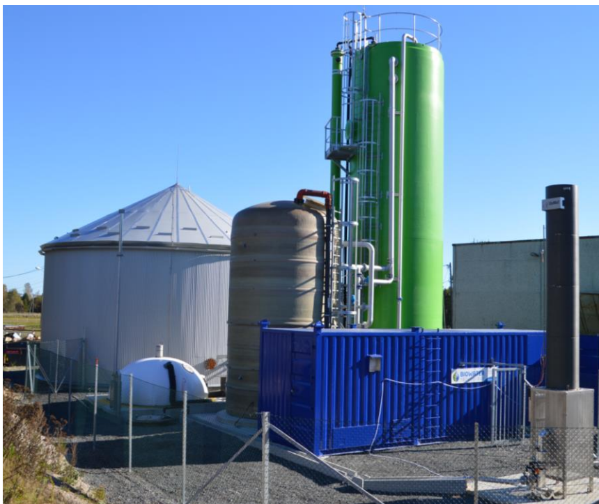
Figur 10. Renseanlegg sett utenfra. De biologiske prosessene skjer i det 14 meter høye rensesårnet avbildet her.
