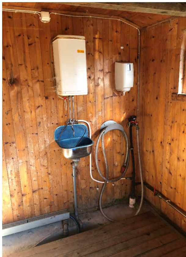
Figur 10 - Eksempel fra arbeidsforhold i en eldre pumpestasjon
