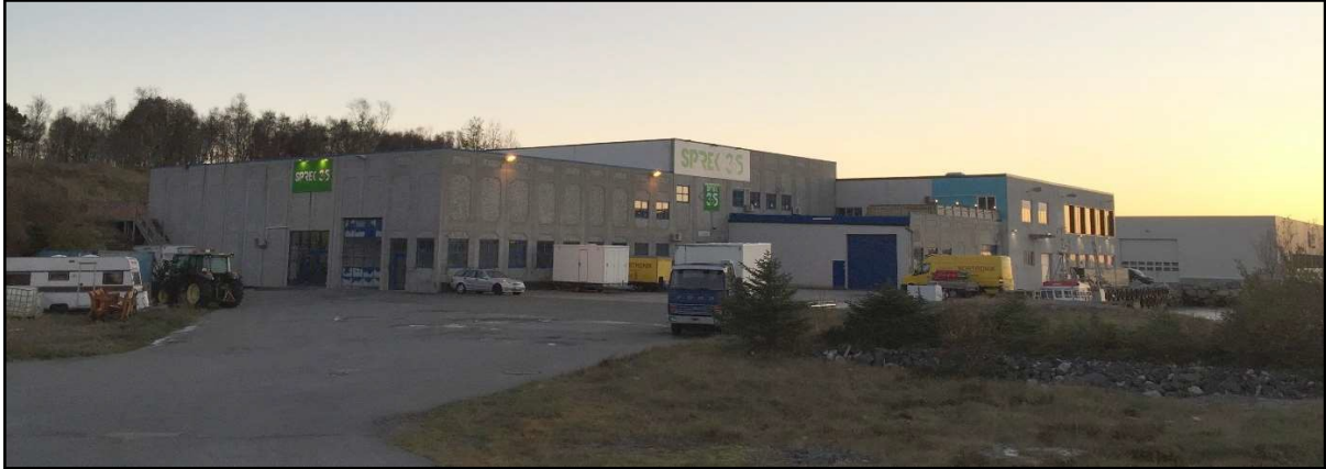
Eksisterende bygg i den sørvestlige delen av planområdet sett fra nord.
