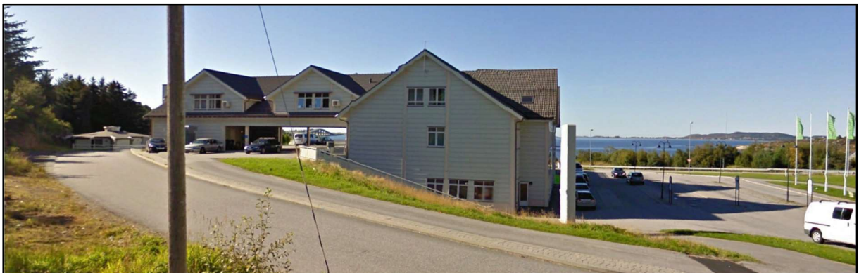
Eksisterende næringsbygg som pr i dag har næringsdrift med hotel, legekontor, catering og dagligvare. Bussholdeplass til høyre og paviljong med motel til venstre.
