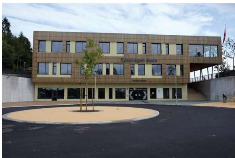
Sydskogen skole er bygget i massivtre, og 14 klasserom huser skolens drøyt 130 elever.
