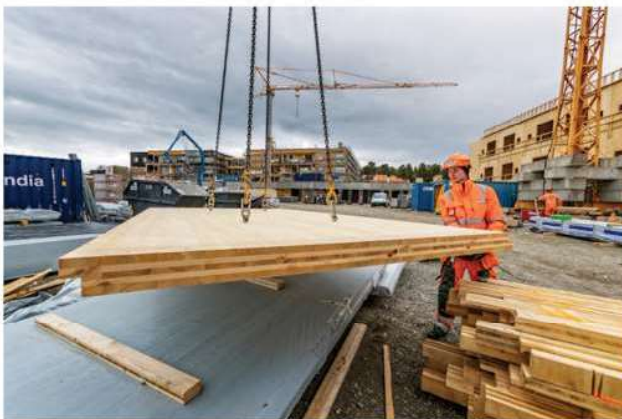
Det er kraner i sving, men i langt mindre omfang enn på andre byggeplasser. (Foto: Alf Ove Hansen)
