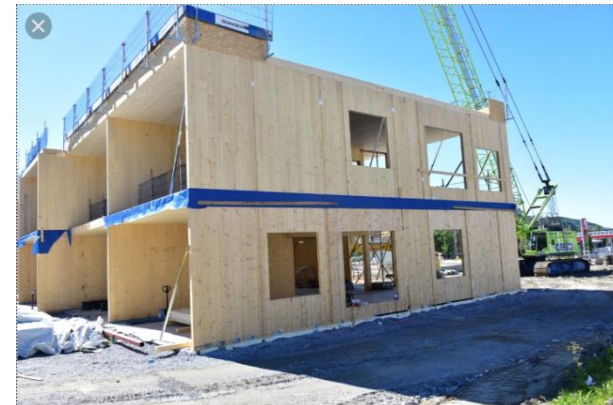
Utgjør bærende vegger/dekker i en bygning
