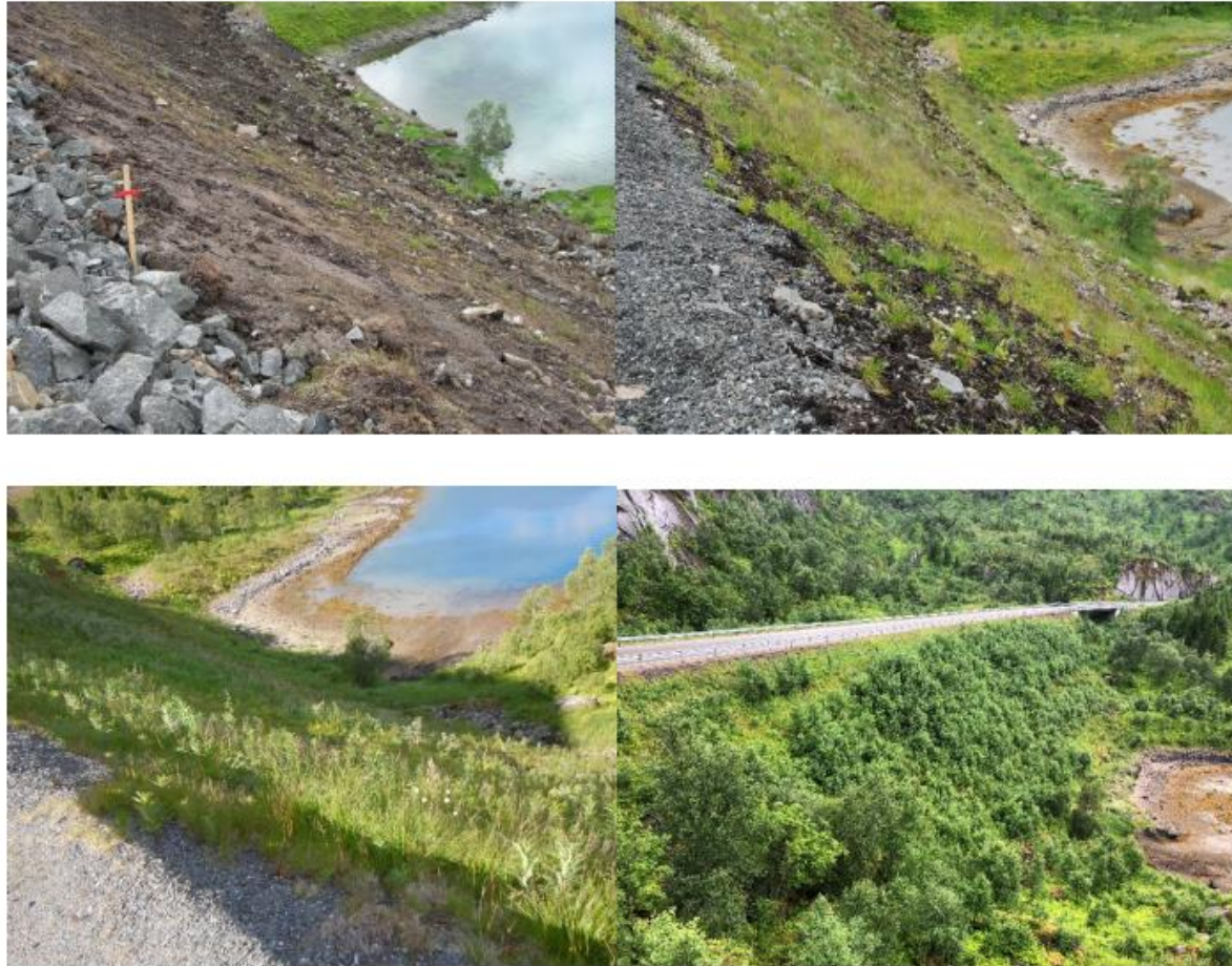
Figur 15. Revegeteringen med toppmasser direkte på bratt steinfylling. Foto: Astrid Brekke Skringdo (2006, 2008 og 2014), Marte Dalen Johansen (2021).
