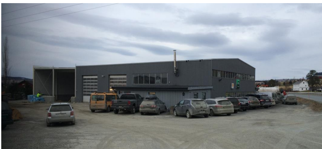
Figur 4: viser eksisterende næringsbygg sett fra sørvest
