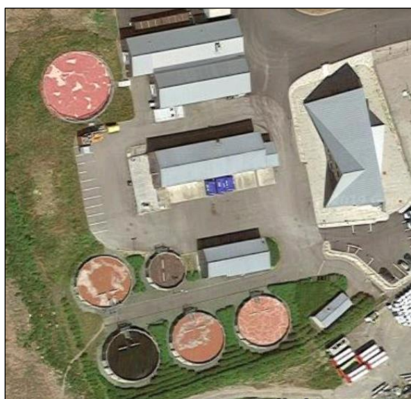
Figur 4.1.2 Flyfoto IVAR renseanlegg Grødalrenseanlegg
