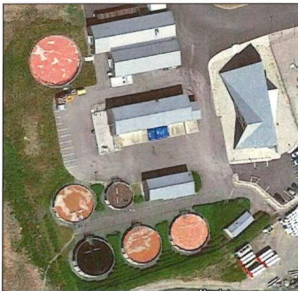
Figur 3.5 Flyfoto IVAR renseanlegg Grødaland
