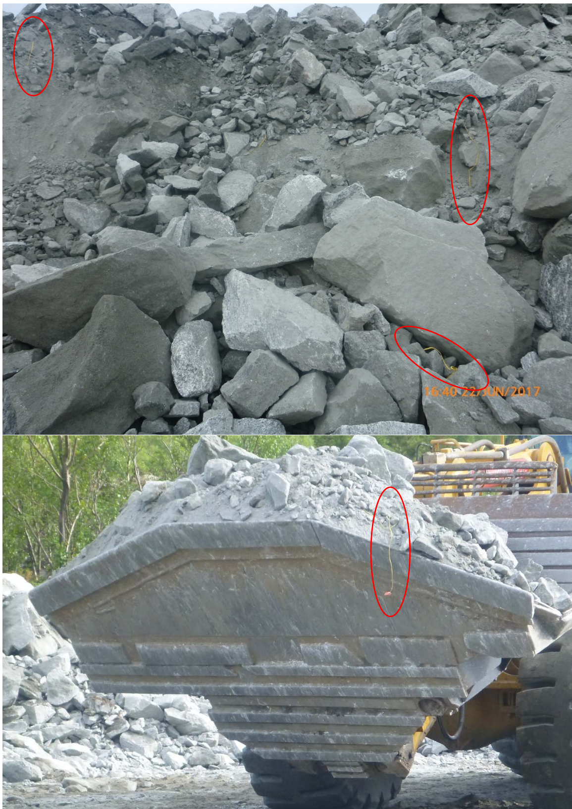
Figur 7: Rester av skyteledning i tunnelmasser
