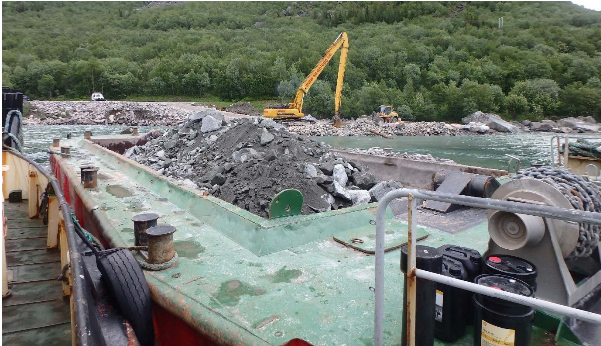
Figur 9: Opplastet lekter på vei til tippsted i sjø
