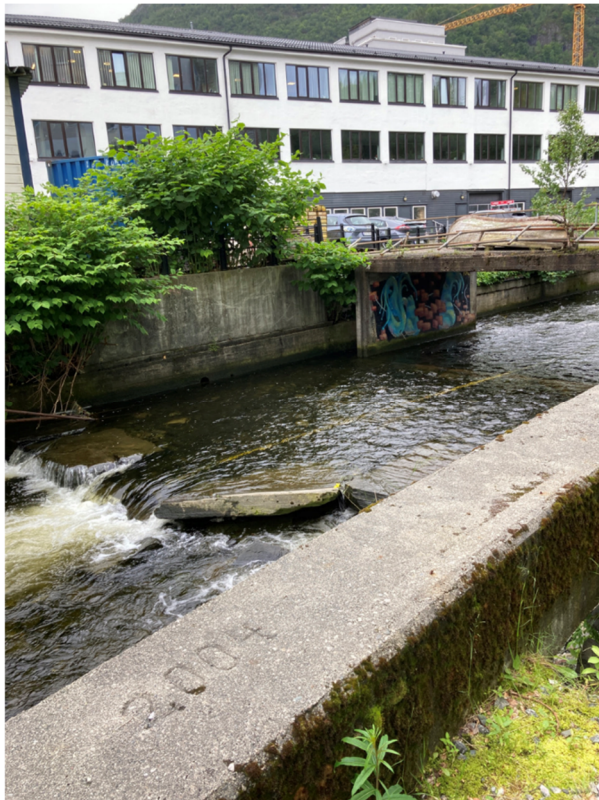
Figur 10: Hele det åpne elveløpet er kanalisert, overveiende med glatte og tette kanalsider. Dette reduserer mengde skjulesteder for fisk og andre organismer, og gir små muligheter for utvikling av kantvegetasjon.
